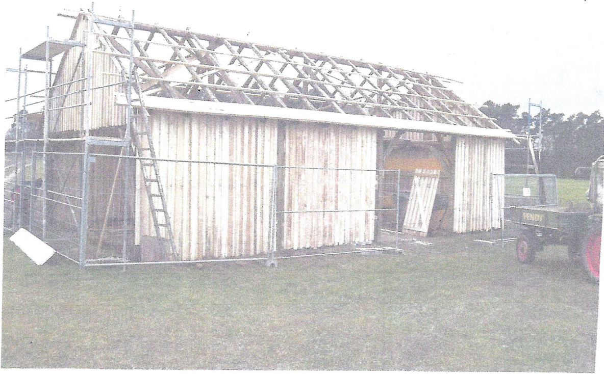
Der neue Besitz hat die alte Scheune vollständig renoviert. er
